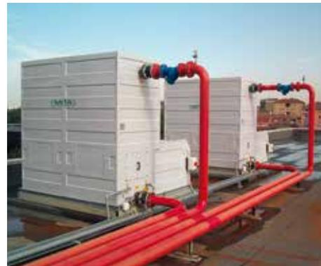
Le torri di raffreddamento serie MCT, costruttivamente basate sul comune concetto di incorrodibilità che contraddistingue tutta la gamma MITA, offrono una soluzione principalmente caratterizzata da alta qualità dei materiali e basso livello di rumorosità, ulteriormente riducibile mediante l'installazione di silenziatori fonoassorbenti.
